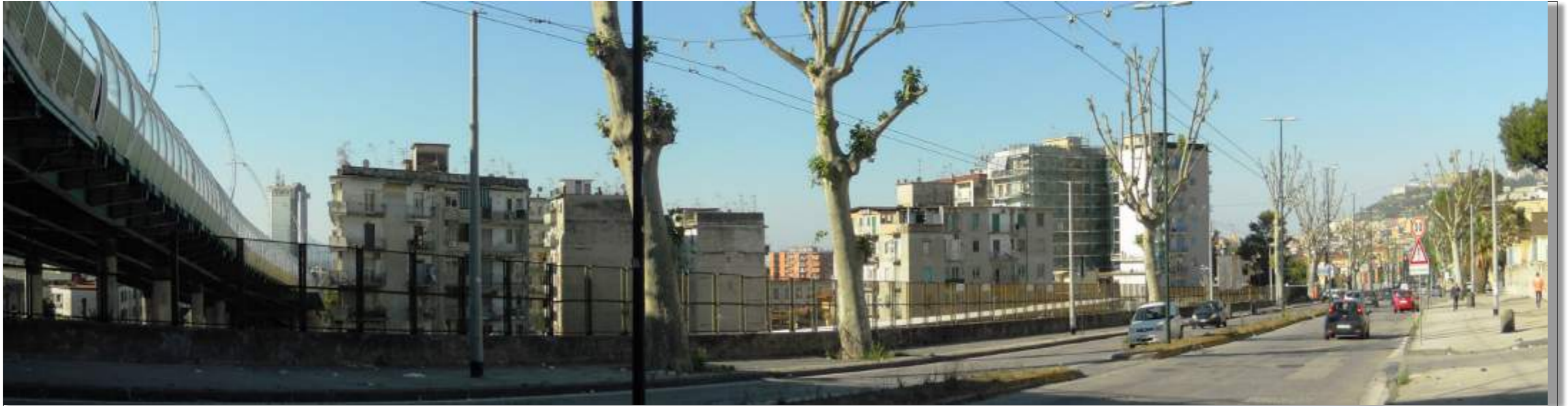
16 — Via don Bosco— Edilizia Residenziale e ponte del raccordo con la Tangenziale
